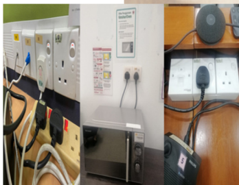
Kabel-kabel yang tidak dilabel
